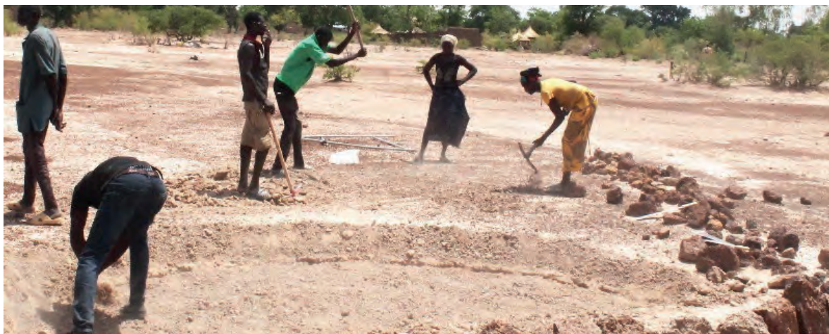
Des agriculteurs/trices des régions du Plateau Central et du Nord du Burkina Faso ont appris avec Inades-Formation Burkina à réaliser des cordons pierreux, des demi-lunes, etc.
